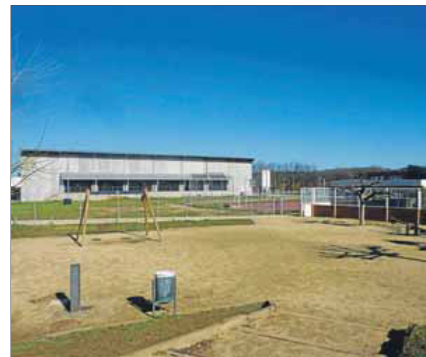
El pavelló i la llar d'infants de Melianta, dos equipaments que es beneficiaran de la xarxa de calor ■ R.E.
