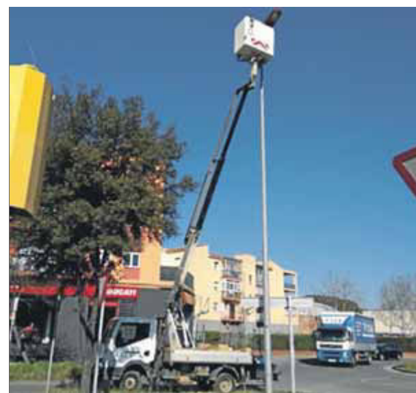
La substitució d'un dels llums de l'avinguda de França ■ E.P.
