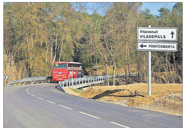
Obres de millora de la carretera GIV-5132. PERE DURAN/NORDMEDIA
