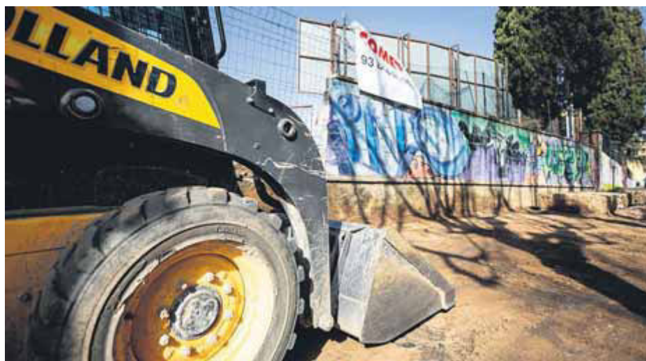
Les màquines han començat a remoure els terrenys per a la caldera de Santa Coloma ■ D.R.
