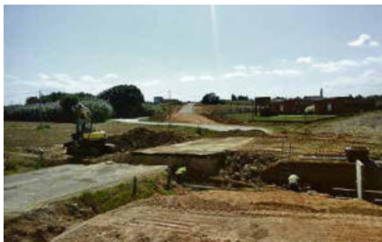
CARRETERA DE VILAFANT. S'hi estan fent treballs per fer el traçat més còmode
